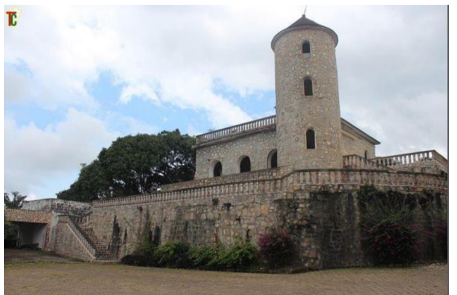
Vue de face du château
